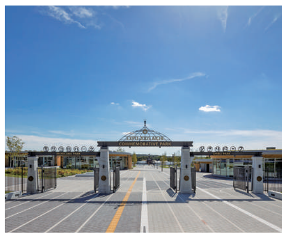
北エントランス入口ゲート 写真はいずれも愛・地球博記念公園管理事務所提供
